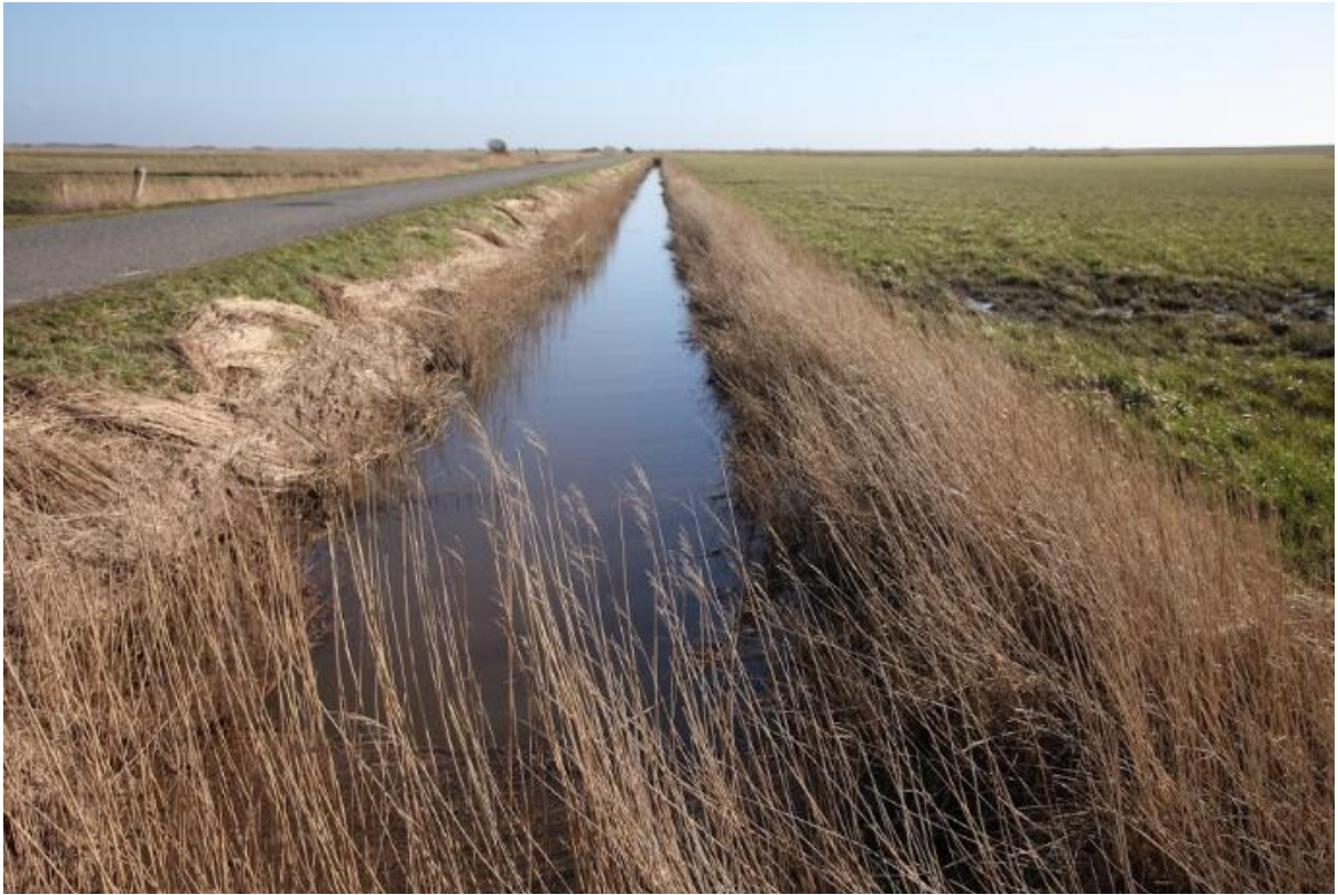
Figur 9 Sdr. Rørskiftekanal. På billedet ses et veldefineret og grødefrit vandløb fra St. 0 m og opstrøms.
