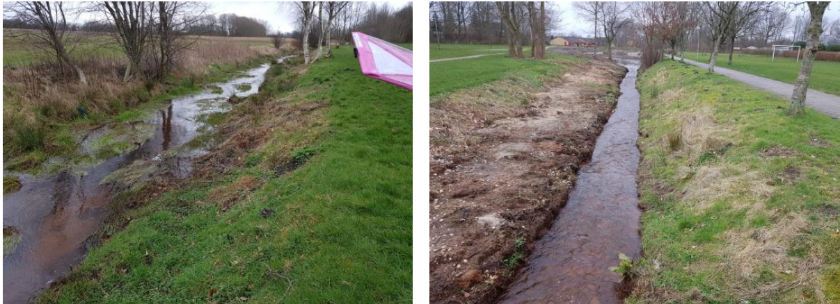
Figur 7 Høe Bæk/ Lysemosegrøften. På billedet tv ses vandløbet omkring st. 1.450 m med grøde i profilet og en veldefineret strømrende. På billedet th ses strækningen umiddelbart opstrøms forsinkelsesbassinet omkring St. 1.500 m, hvor der er foretaget bundoprensning.
