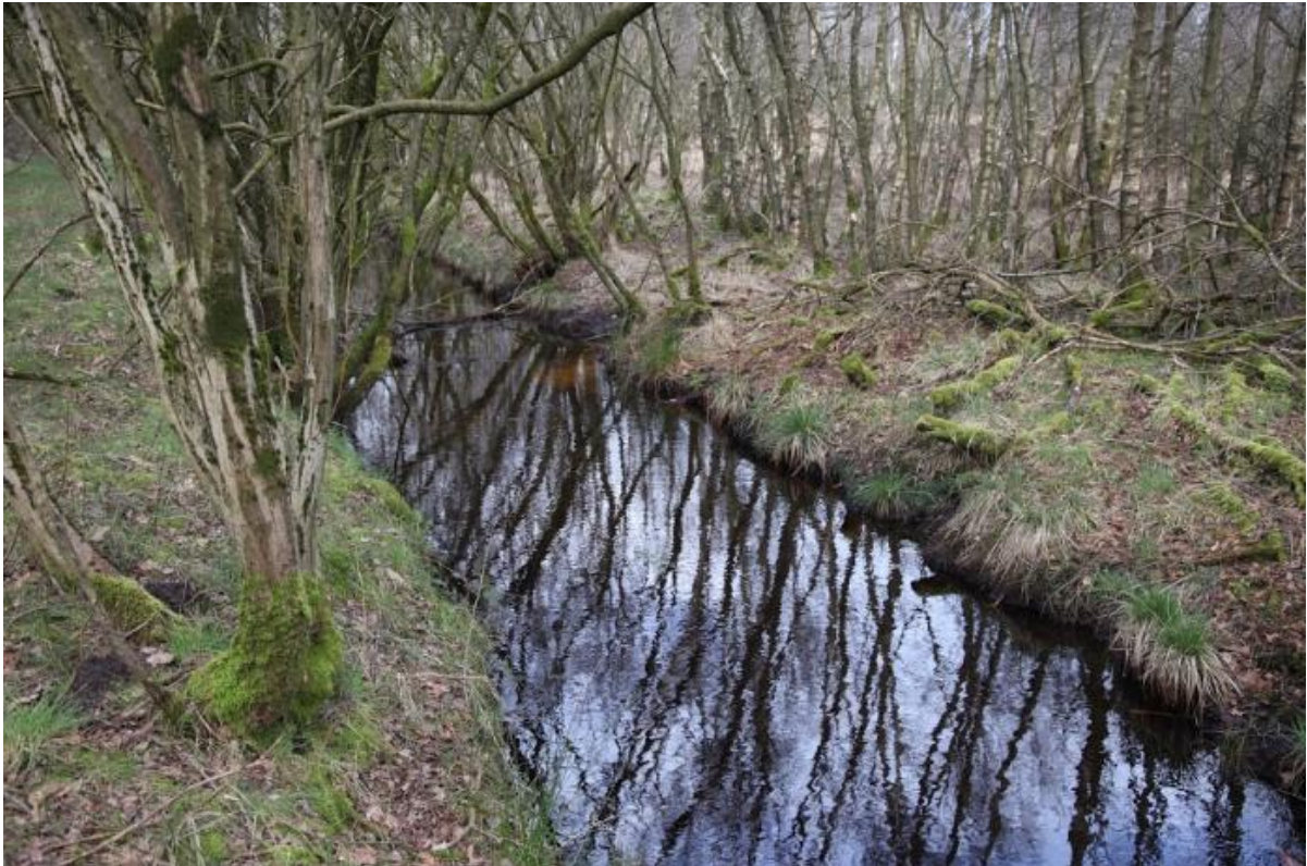
Figur 18 Langskifter Kanal. På billedet ses et tilgroet naturområde langs vandløbet omkring St. 1.000 m. Samtidig ses et overbred vandløbsprofil.
