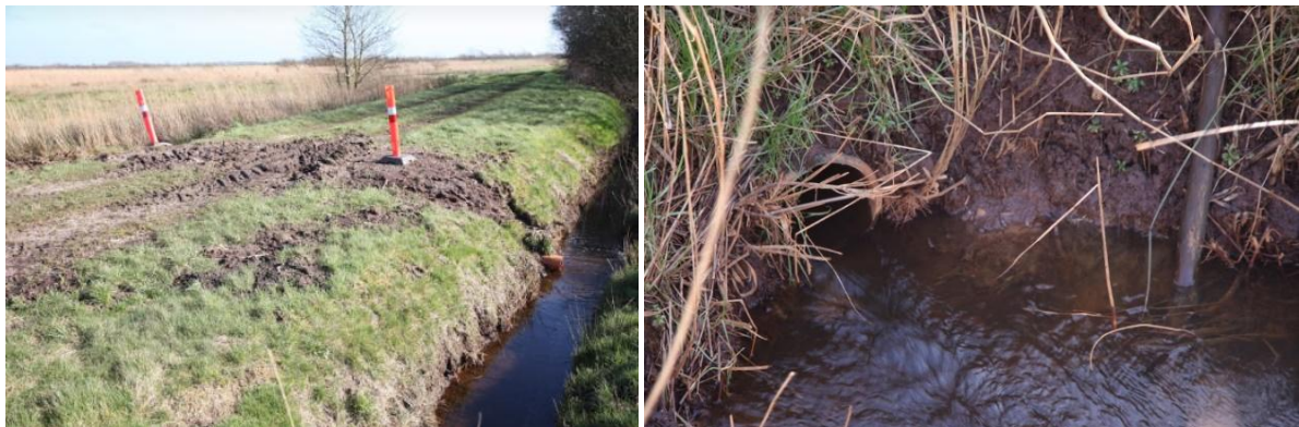
Figur 6 Søndermose Kanal. På billedet tv ses den nye vejunderføring ved St. 1.700 m, som er anlagt ved de røde markeringspæle. På billedet th ses vandstrømning i udløbet fra vejgrøften. Hovedrøret for vandløbet er neddykket i billedets venstre side, hvor der ikke sker afstrømning.
