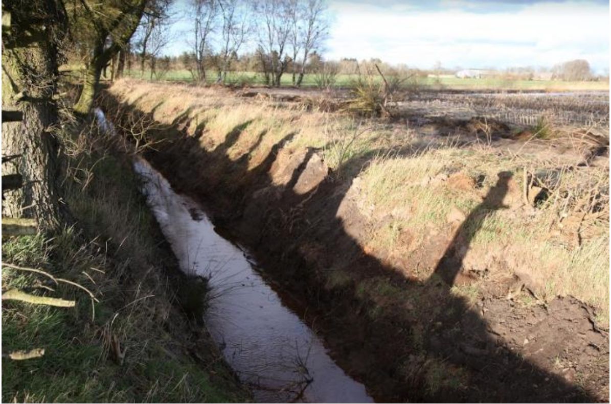
Figur 1 Faurholt Vestre Bæk. På billedet ses oprensningen af vandløbets bund ved ca. St. 1.400 m. Der er endvidere oplagt opgravet materiale på marken på modsat side af vandløbet.
